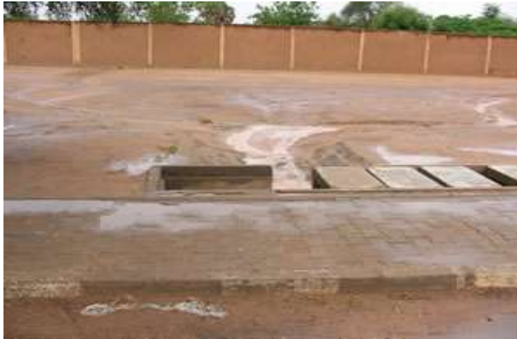
Photo 10 : Canal d'évacuation des eaux pluviales.
