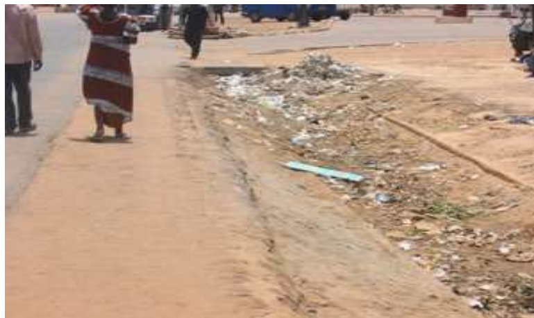
Photo 11 : Canal d'évacuation à ciel ouvert des eaux pluviales qui sert de déversoir d'ordures.
