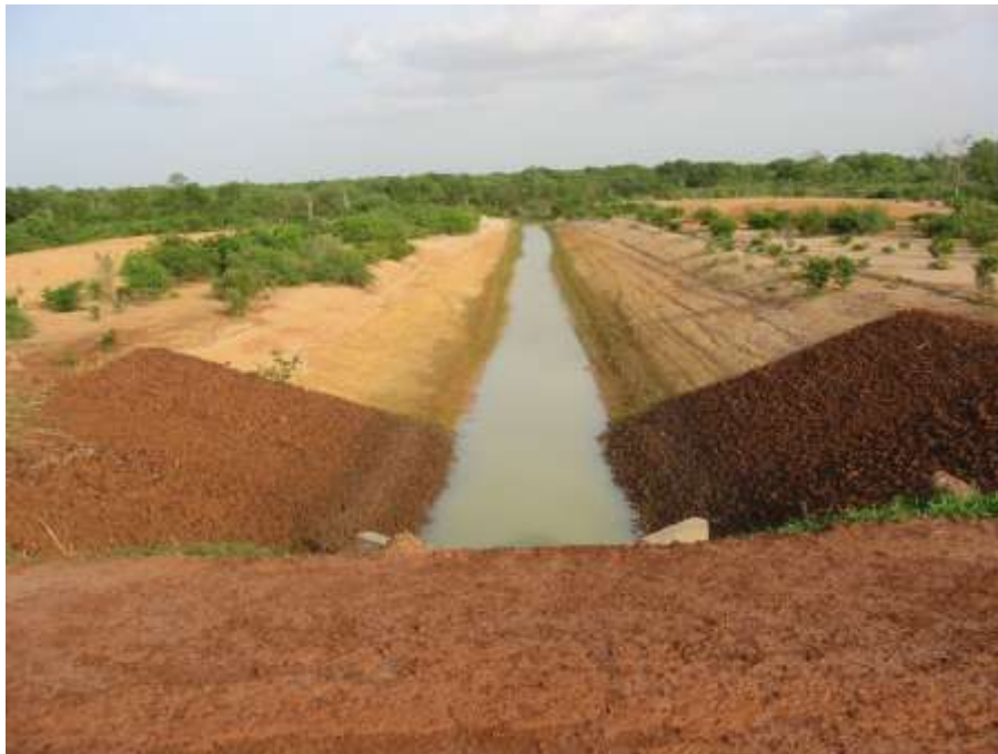
Photo 2 : Un canal d'irrigation aménagé par la SODAGRI sur l'Anambé pour la riziculture.
