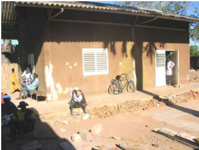
Photo 5 : Poste de Santé de Malem Niani en chantier
