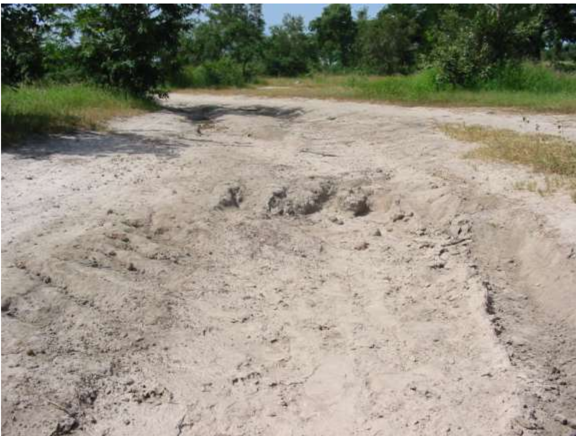
Photo n° 3 : L'état de dégradation de la piste qui mène à Médina Touat
